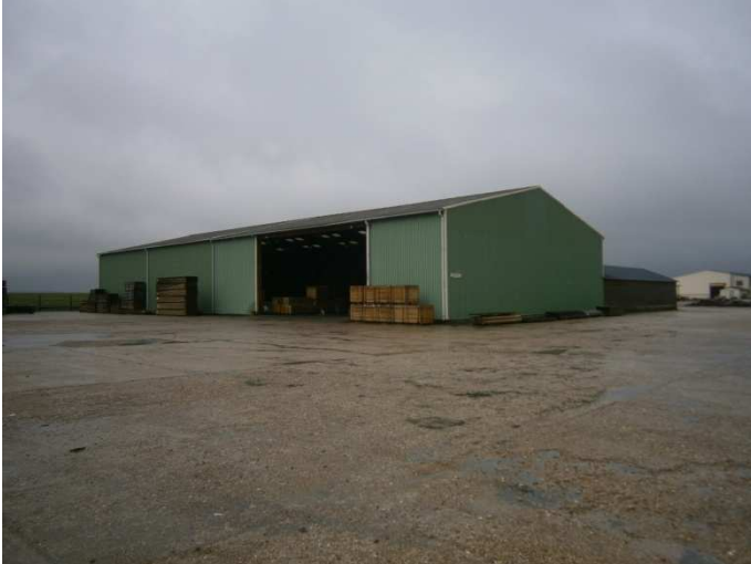
Figure 11.12. : 2 photos du bâtiment de traitement des bois
